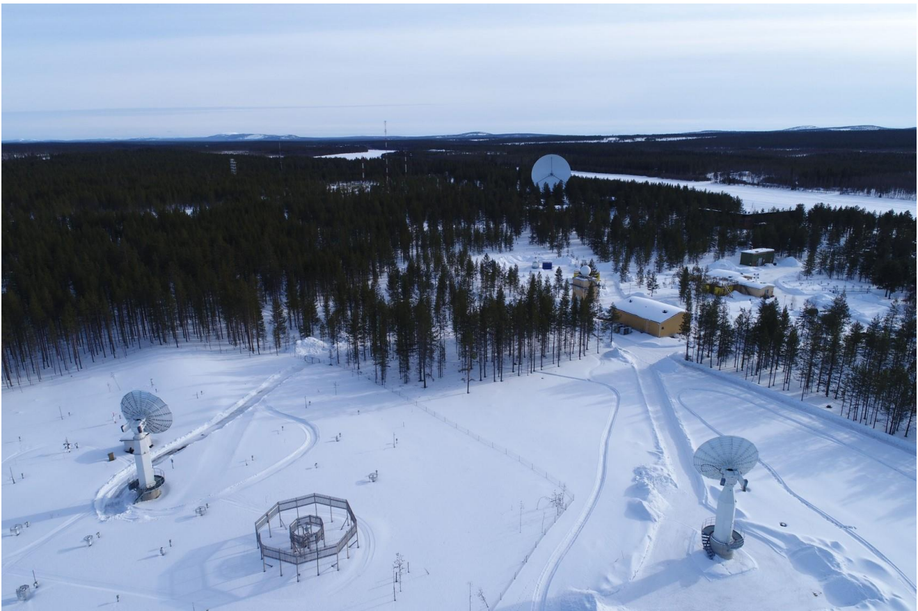
Kuva 1. Sodankylän satelliittidatakeskus. Etualla keskuksen kaksi 7,3 metristä vastaanottoantennia (SOD02 ja SOD03). Taustalla EISCAT-yhteenliittymän (European Incoherent Scatter Scientific Association) 32 metrinen tutkavastaanotin.
